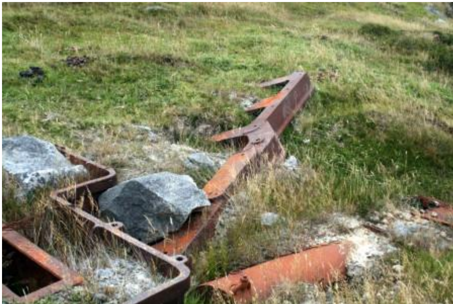
Restos de mástiles a instalaciones originales VPC
